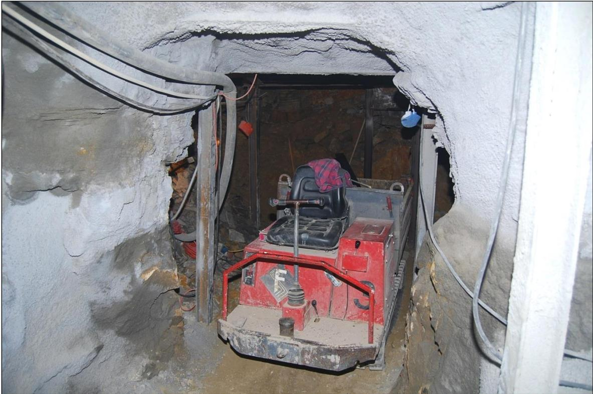
Abb.5 : Aufwältigungs- und Sicherungsarbeiten in den teilverbrochenen Grubenbauen mittels Kleintechnik. Die Streckensicherung erfolgt mit Spritzbeton.
