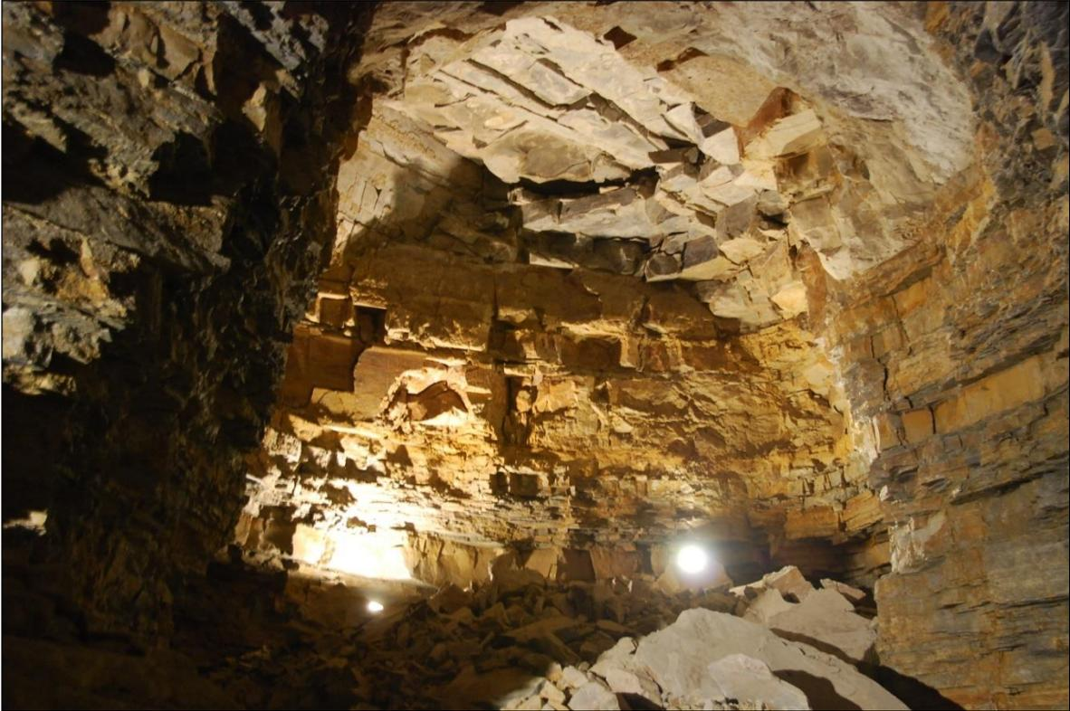
Abb.4 : Bild 4: Aktiver, domartiger Hochbruch in einer großen Abbaukammer
