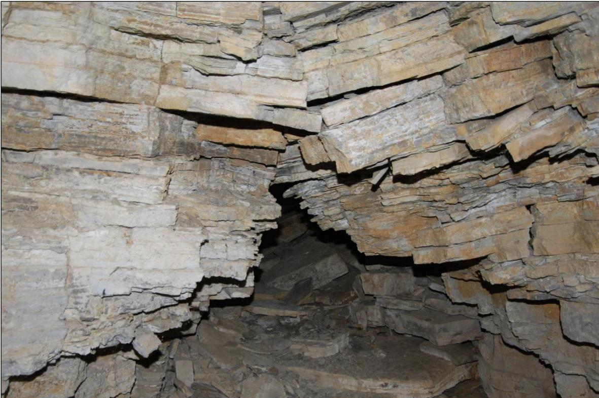
Abb.1 : Verbruch der entfestigten Deckgebirgsschichten über den Grubenbauen
